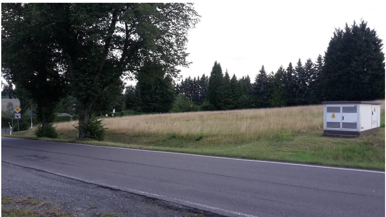
Abb. 3: Blick über die nordwestliche Ecke auf den Bereich des Vorhabens (Foto: 08.08.2024)
