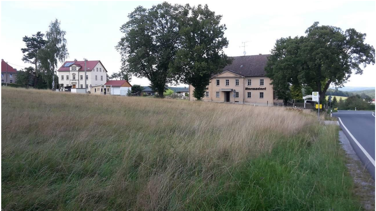
Abb. 4: Blick von der südöstlichen Ecke auf den Bereich des Vorhabens (Foto: 08.08.2024)
